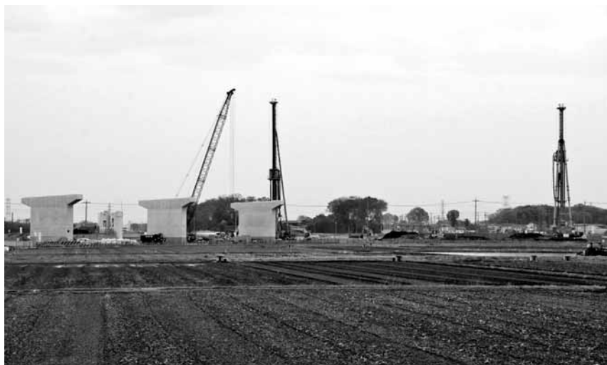
工事が進む五霞 | C (江川地区)
