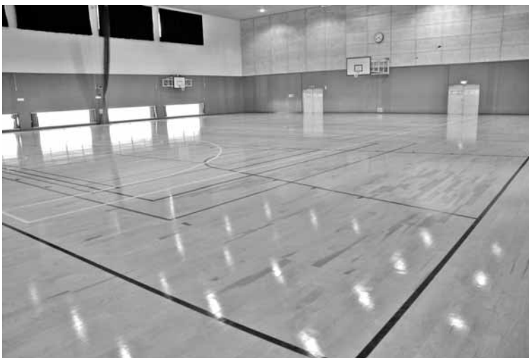
改修したB & G体育館床
