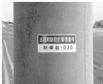
電柱貼付の管理番号
