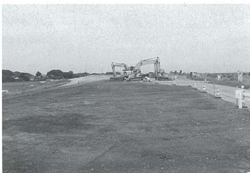
堤防拡幅（上段盛土）の実施状況
