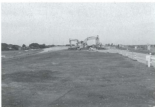
堤防拡幅（上段盛土）の実施状況
