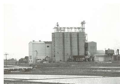
カントリーエレベーター
