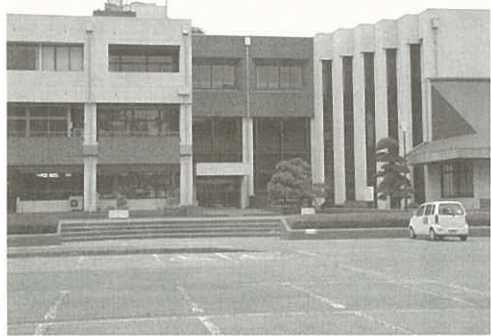
耐震補強が求められる中央公民館
