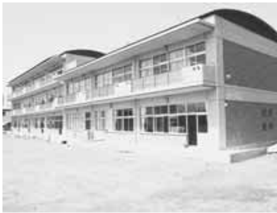
完成した五霞中学校の普通教室
