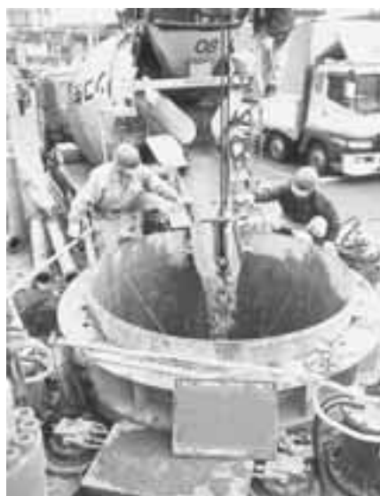
公共下水道工事
