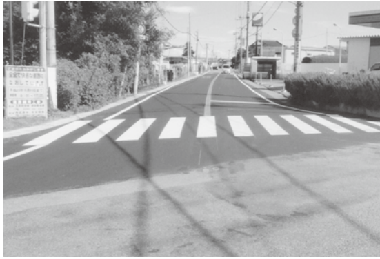
町道54号線道路舗装工事
